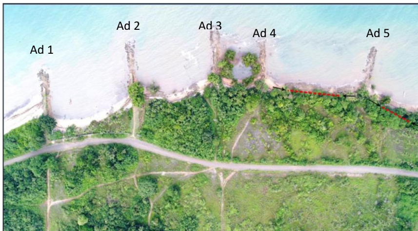
Gambar 6. Foto drone memperlihatkan lima Army dock dengan garis pantai berbentuk cekung bekas pengerukan di antara ruas Ad1-Ad3 (Sumber: Dokumen Balair Maluku, 2018)
